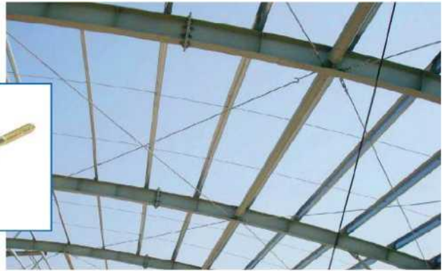
Giăng kết cấu mái bằng ty ren 2 đầu
