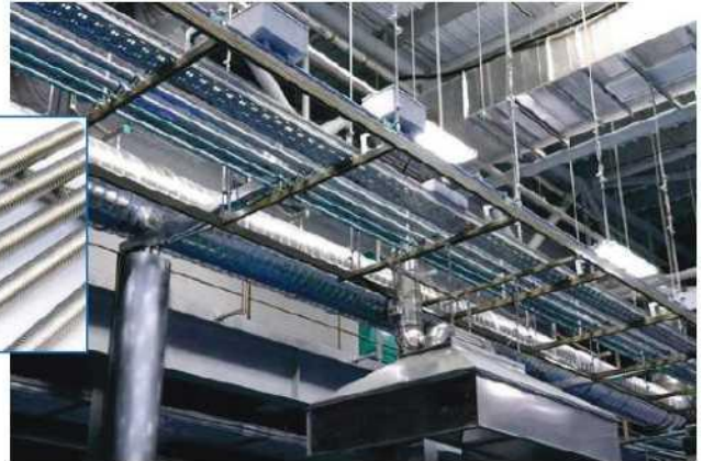
Treo hệ thống cơ điện bằng ty ren xuyên suốt
